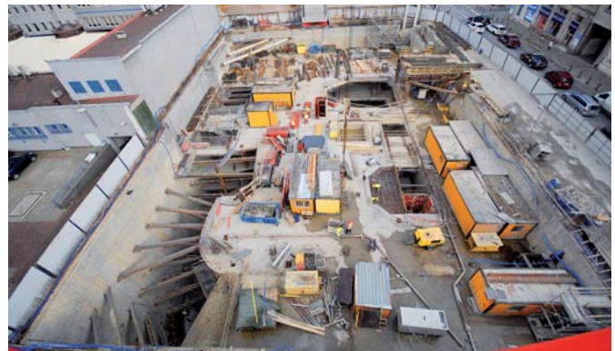
Widok na plac budowy – Wolf Marszałkowska
