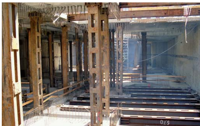
Słupy tymczasowe i rozpory przed demontażem – Wolf Bracka
