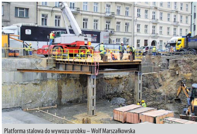
Platforma stalowa do wywozu urobku – Wolf Marszałkowska
